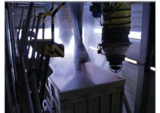
Wasserdampfbildung 300° heisser Stäube bei der Aschebefuchtung
